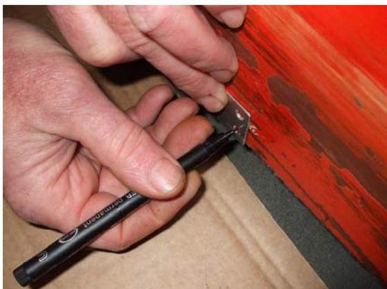
3. Markieren Sie mithilfe des Bleches die Bohrpunkte an der Installationsfläche.
