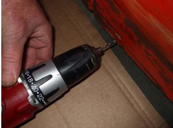
5. Platzieren Sie die Bohrungen für die Bleche und den Kabeldurchgang.
