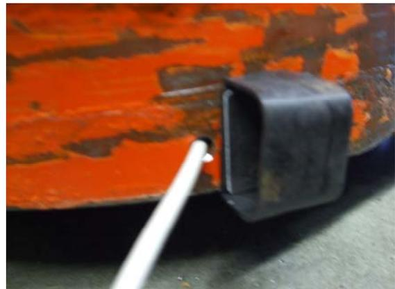
9. Führen Sie das Kabel durch eine vorbereitete Bohrung in der Installationsfläche weg.
